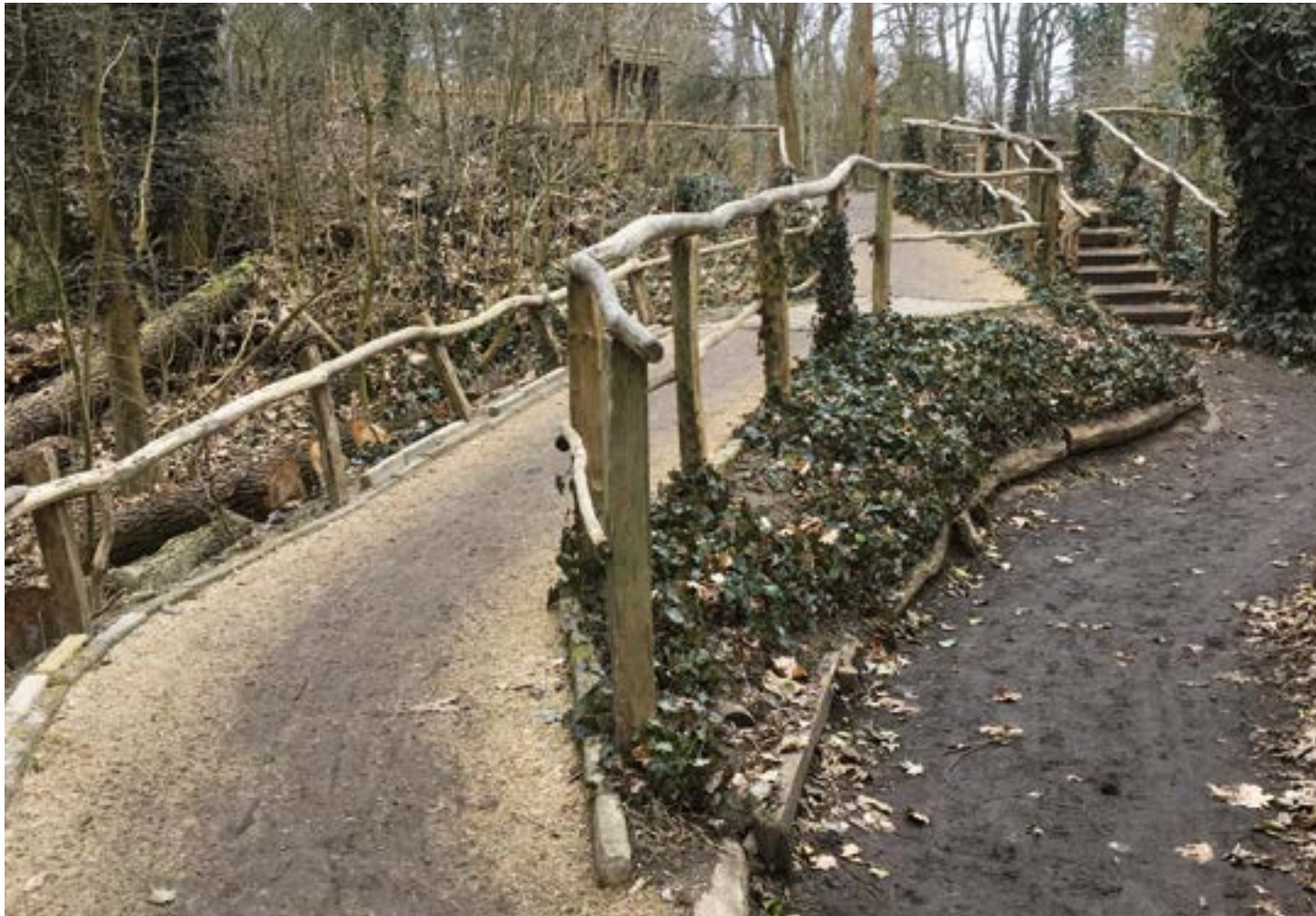
Kép: A lépcsők helyett alkalmazott alternatív megoldások sok esetben jól beilleszthetők a tájképbe. A képen a lépcsők mellé épített ramba látható a Berlinben található Kleiner Spreewald Szabadidőparkban.
